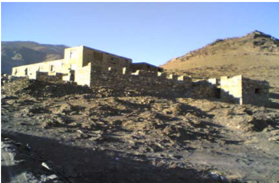
Die ersten Mauern der Schule in Kohna Khomar
