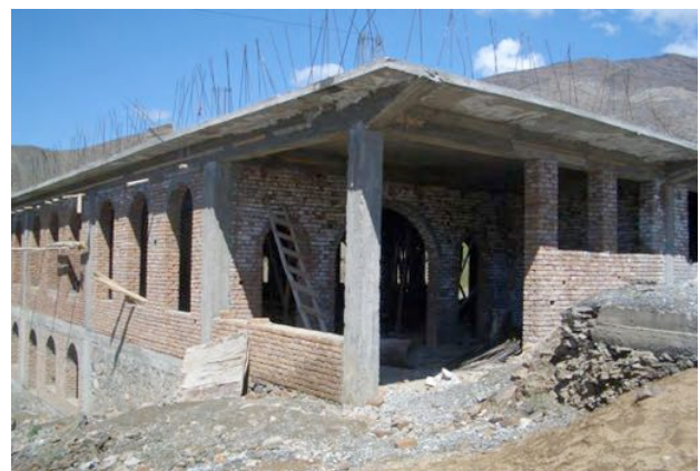
Rohbau von zwei der geplanten 3 Etagen der neuen Moschee in KK (Photo Safi Baborie, Mai 2014)
